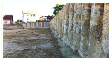
En ce début août ont démarré les travaux de construction de "l'immeuble Séniors". Après la première phase d'ouverture du chantier marquée par l'évacuation massive de déblais (environ 10 000 m<sup>3</sup>), et la mise en place préalable et très impressionnante de 120 piliers de béton armé en vue de la consolidation du site, ce début septembre à vu le démarrage de la construction proprement dite par le coulage des premières fondations.
